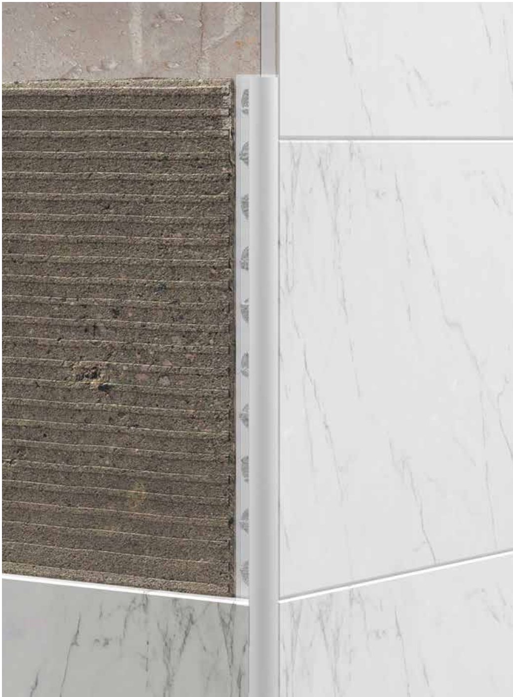
Colocación perfil PVC Blanco
